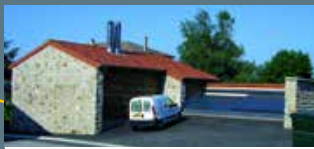
Jonzieux Réseau de chaleur
