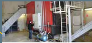
Montrond les Bains Réseau de chaleur
