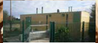
St Maurice en Gourgois Réseau de chaleur
