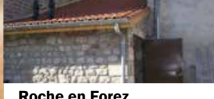
Roche en Forez Réseau de chaleur
