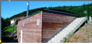
La Terrasse sur Dorlay Réseau de chaleur
