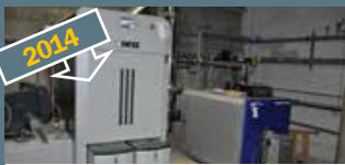
Colombier Réseau de chaleur
