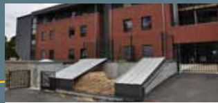
Marlhes (2) Réseau de chaleur
