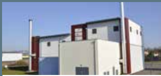
Andrézieux-Bouthéon Réseau de chaleur
