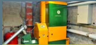
Luriecq Réseau de chaleur
