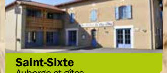
St Symphorien de Lay Réseau de chaleur
