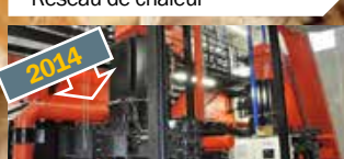
St Christo en Jarez Réseau de chaleur
