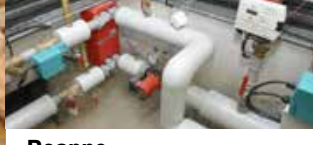
Roche en Forez Réseau de chaleur
