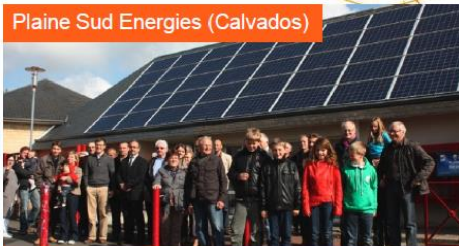
Toitures photovoltaïques sur les écoles d'une communauté de commune
