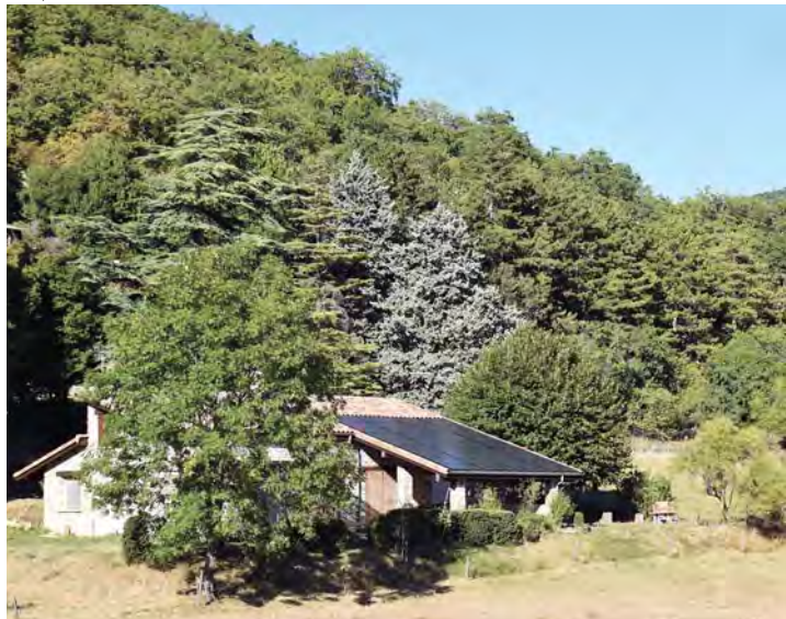
La centrale de Gervanne-Raye dans la Drôme va ajouter l'an prochain cinq nouvelles toitures aux six déjà équipées.
