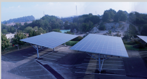
Ombrières de Champniers (crédit photo : SCIC PCER)
