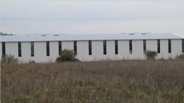
Installation photovoltaïque de Caunes-Minervois (crédit photo : Mairie)
