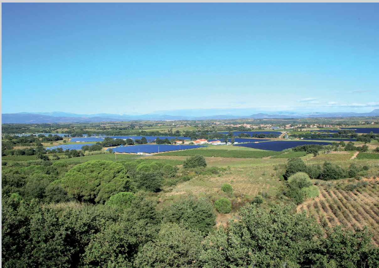
Parc photovoltaïque au sol à Ortaffa (crédit photo : © R. Roig / juwi EnR).
