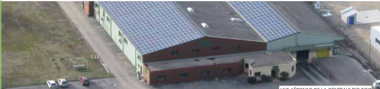
VUE AÉRIENNE DE LA CENTRALE PIC BOIS
