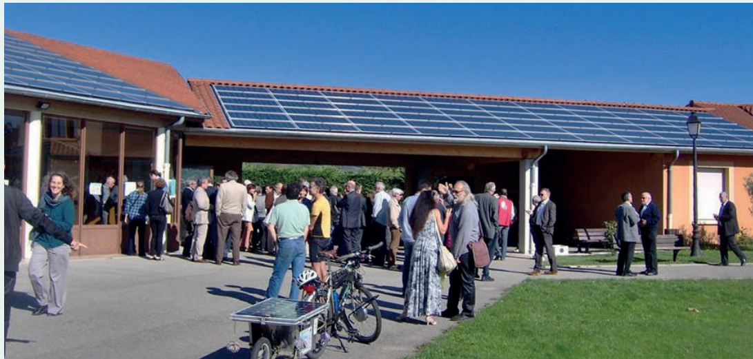
Centrales Villageoises de la région de Condrieu : Inauguration des 1ères installations photovoltaïques sur la commune des Haies Photo : Centrales Villageoises
