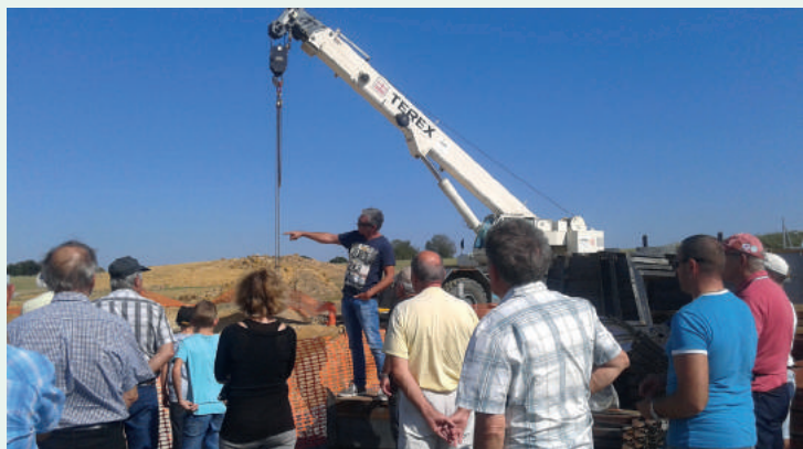
Visite du chantier du parc éolien participatif des Brandes Photo : Lumo
