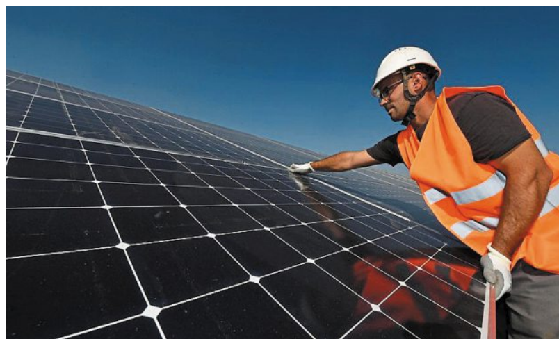
Une quarantaine d'ouvriers sont déjà à pied d'œuvre sur le chantier. Le montage des panneaux a commencé en début de semaine.
