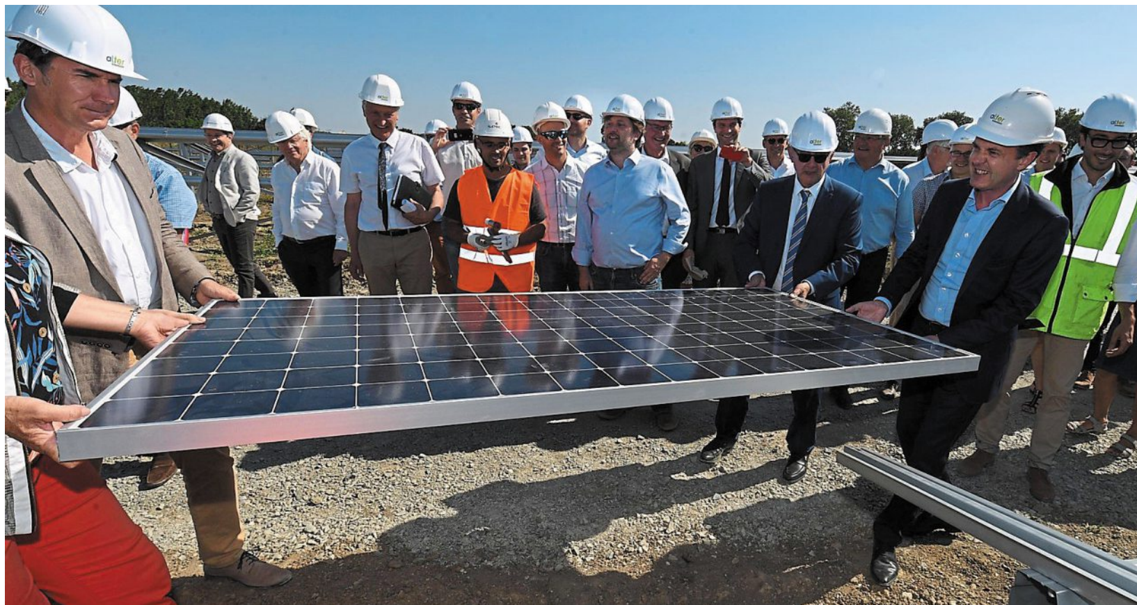
Les élus des Ponts-de-Cé et différents représentants d'Angers Loire Métropole, dont le président Béchu, ont symboliquement posé un module photovoltaïque
