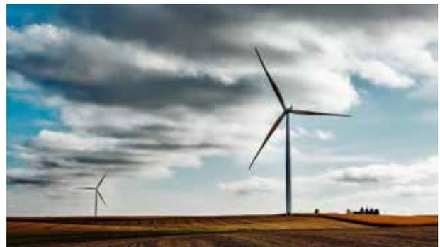
Lointaines héritières des quelques 20 000 moulins à vent qui animaient au XVIII<sup>ème</sup> siècle les campagnes françaises, les éoliennes transforment l'énergie cinétique du vent, d'abord en énergie mécanique via leur rotor puis en énergie électrique via un alternateur se trouvant dans la nacelle située derrière le rotor. Le courant électrique est ensuite transformé via un redresseur puis un onduleur avant d'être injecté dans le réseau.
