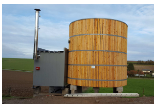
Micro-chaufferie collective au bois - 3 sites - 480 kW
