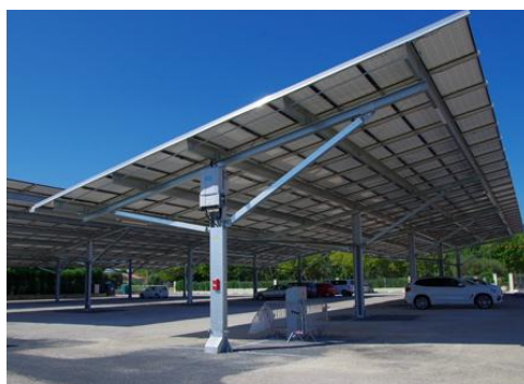
Ci-dessous : Modèle en "V" ou en "W" - Photo : TerreSolaire (modèle en épi), Adiwatt & Carport Solaire
