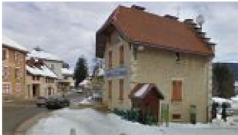
Pente du toit forte
