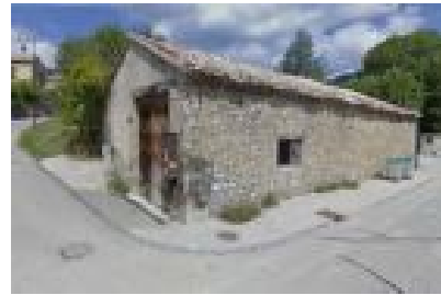
Pente du toit faible
