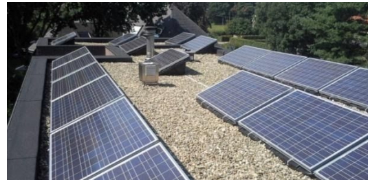
Exemple en toit terrasse, sur bac lestés
