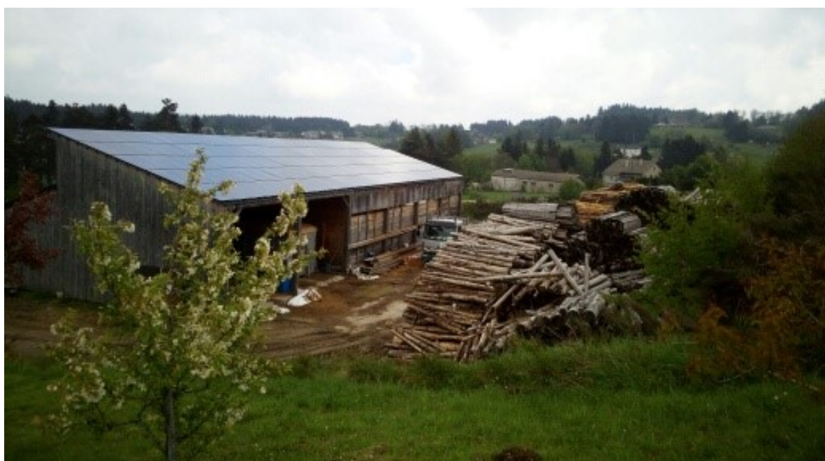
La plateforme du Mazet-St-Voy (43) permet d'alimenter 5 chaufferies communales ultra-localement
