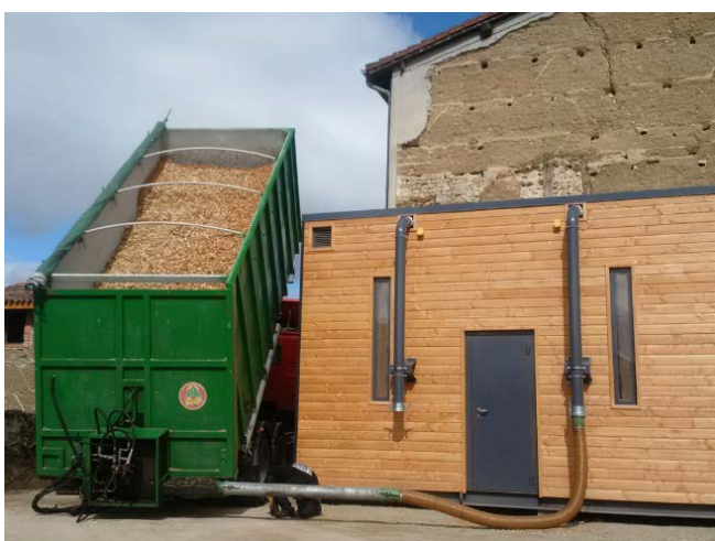
La majorité des chaufferies implantées sont des modules, préfabriqués, ossature bois ou métal.
