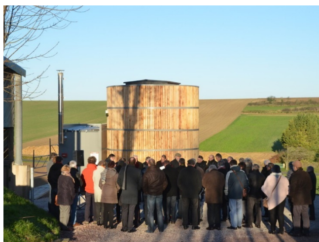
La majorité des chaufferies implantées sont des modules, préfabriqués, ossature bois ou métal.
