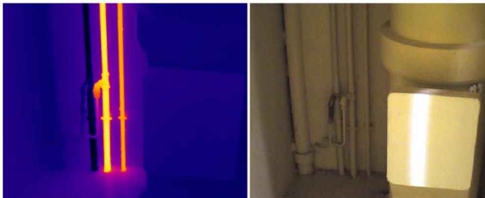
Figure 9 Réseaux ECS non isolé
