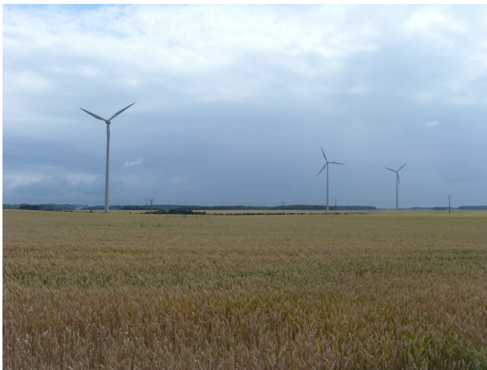
Figure 2 : Parc Eolien en milieu agricole Source : SER
