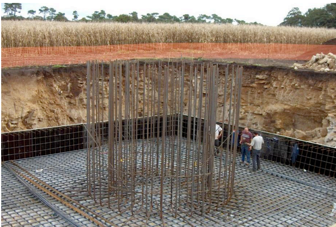
Figure 12 : Fondations d'une éolienne Source : Compagnie du Vent
