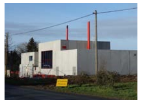
La nouvelle chaufferie biomasse + gaz le long de la route départementale
