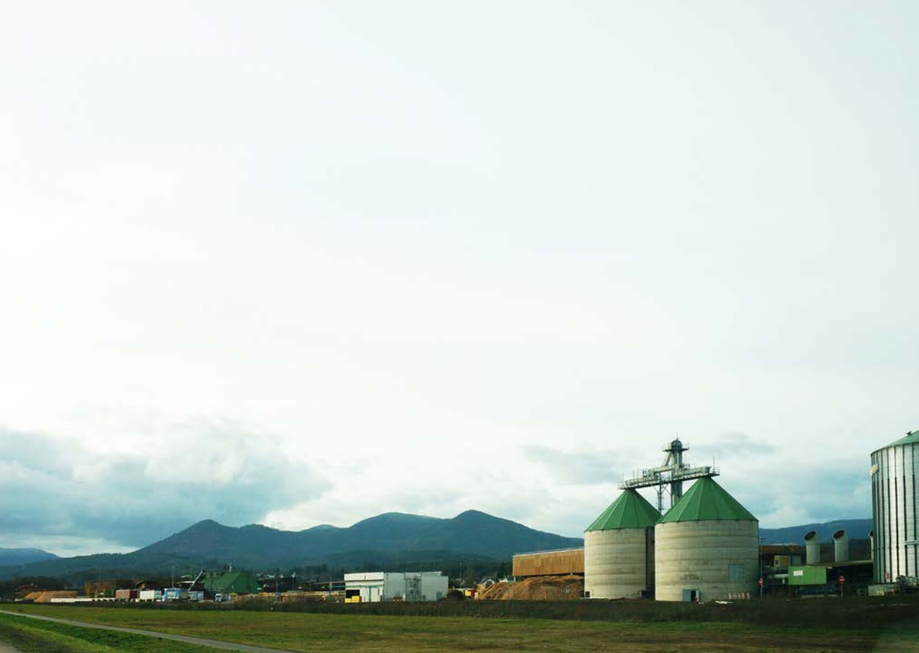
Les bâtiments de la scierie SIAT à l'entrée de la vallée de la Bruche
