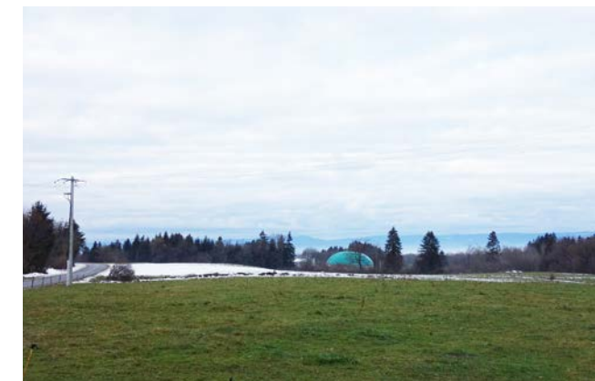
Vue du méthaniseur depuis la route départementale, le Lac Léman dans le lointain
