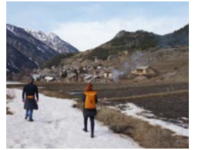
La conduite forcée sous la piste d'accès aux jardins
