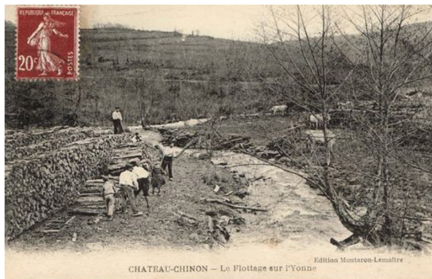
Carte postale ancienne. Le flottage sur l'Yonne, Château-Chinon. L'image montre bien l'exploitation forestière des pentes des massifs et l'utilisation de la force du courant hydraulique pour le transport des bûches.
