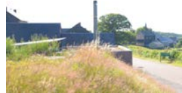
Bâtiment de la chaufferie communale de Glux-en-Glenne
