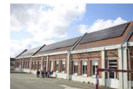
Ici, les toitures des bâtiments de l'école sont recouvertes de panneaux solaires sur la totalité, encadrées d'une bordure de tuiles. © P.Delance
