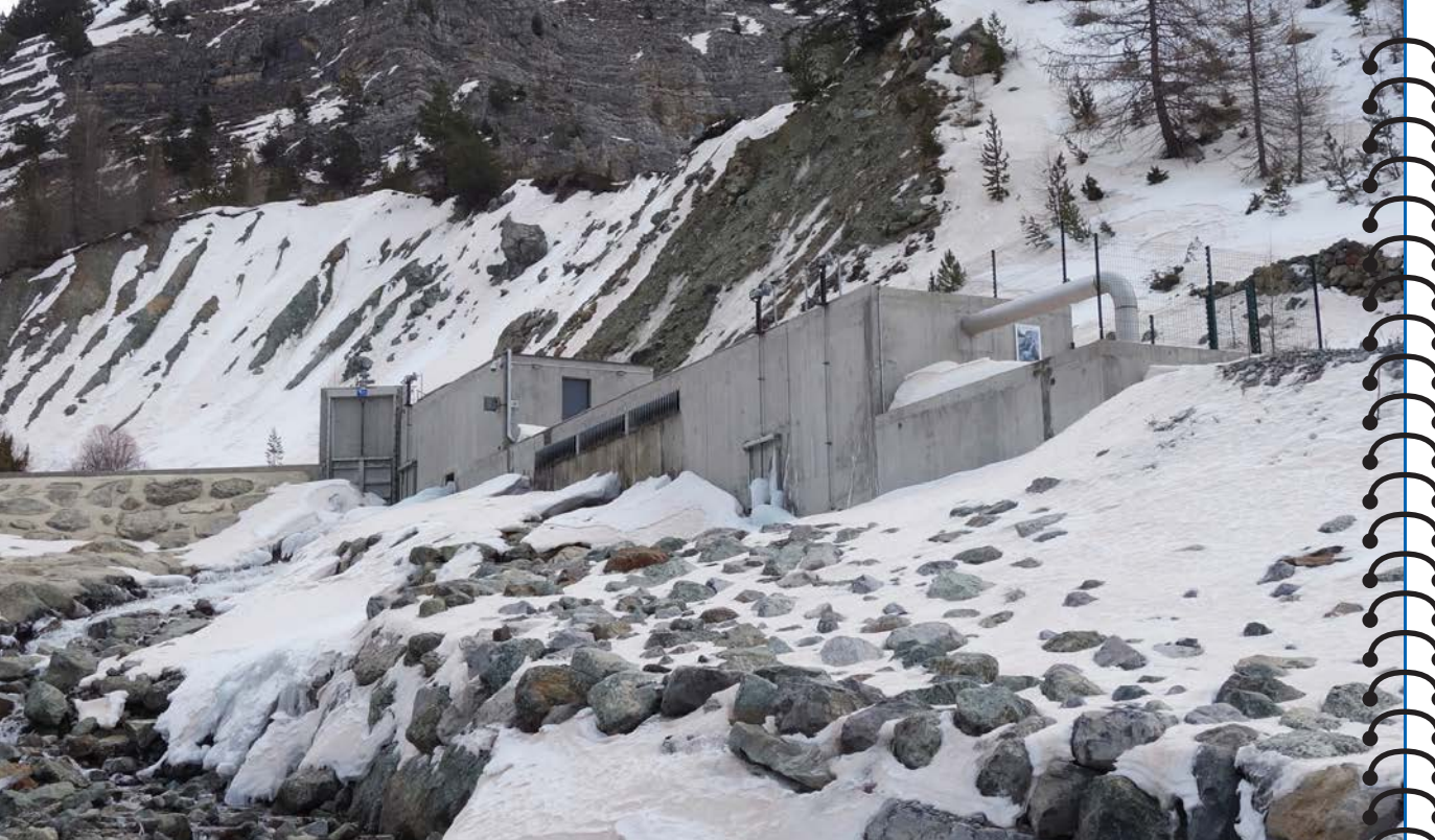
Le mur de barrage et le bâtiment de la prise d'eau
