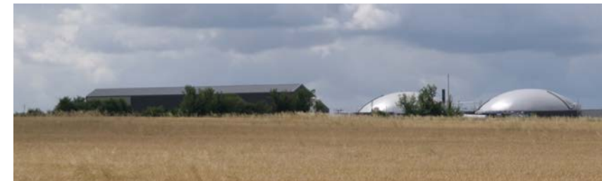
Vue sur le site de méthanisation depuis la route départementale, à travers la plaine agricole
