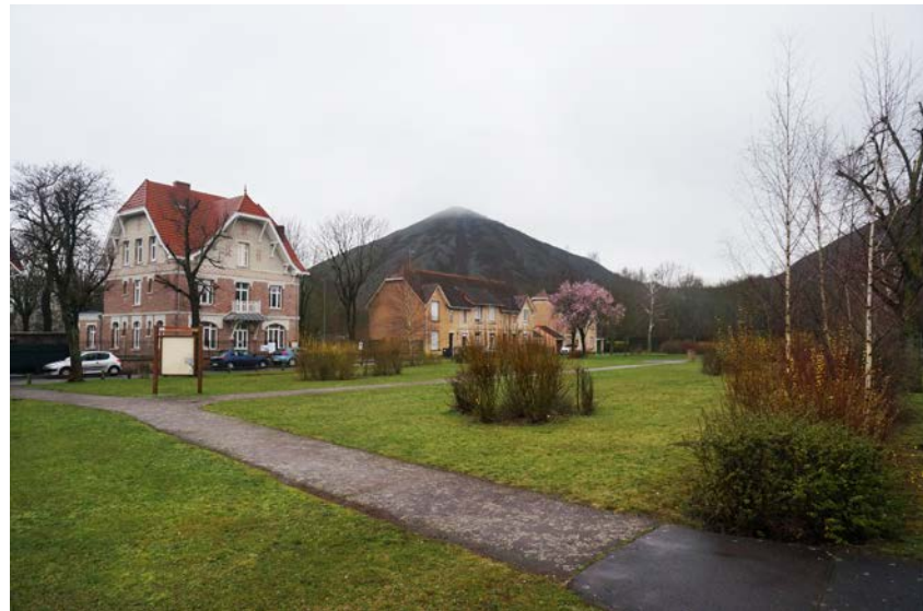
Maison démonstratrice du projet Réhafutur à Loos-en-Gohelle. L'objectif est de proposer des solutions de rénovation de l'habitat minier avec de hautes exigences énergétiques, environnementales, économiques et sociales.
