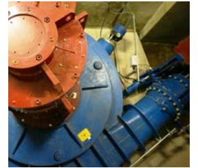
La turbine transformant l'énergie hydraulique en électricité
