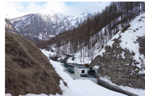
L'ouvrage de la prise d'eau
