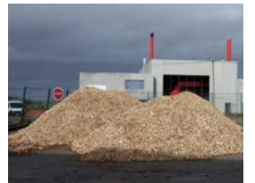
Copeaux de bois pour la chaufferie
