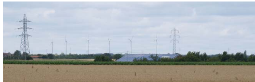
Parcs éoliens existants au nord du PNR.
