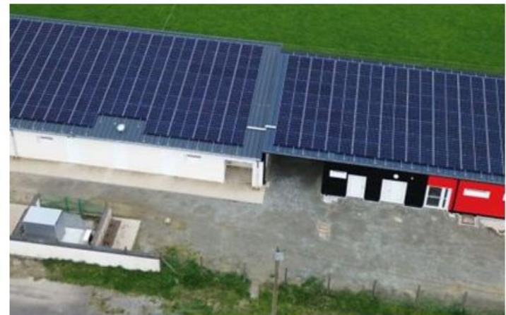
Installation PV d'Energ'iV
