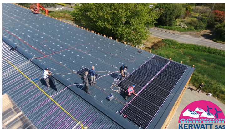
Installation des panneaux sur le magasin Tinatur à Trémuson (22)
