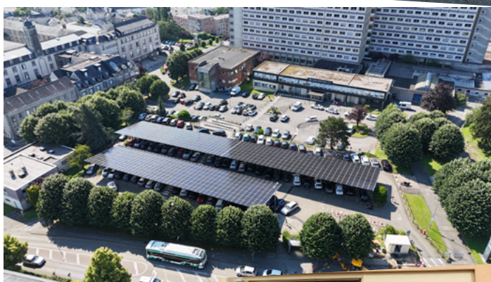
15 octobre 2024 Ombrières de Mayenne CHU de Laval
